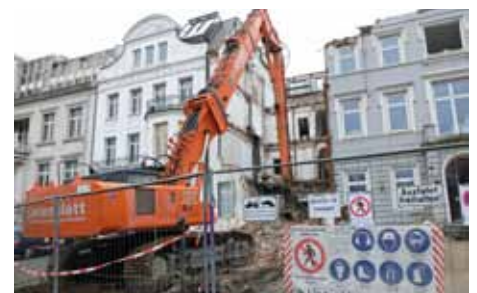
Abbrucharbeiten für die schicken Neubauten (Foto von Mathias Thurm)
